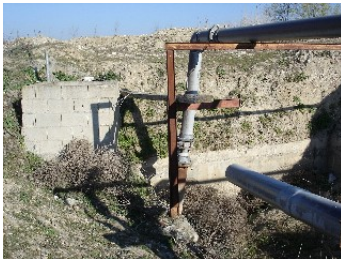
Pozo de agua cercano a La Torrecilla
